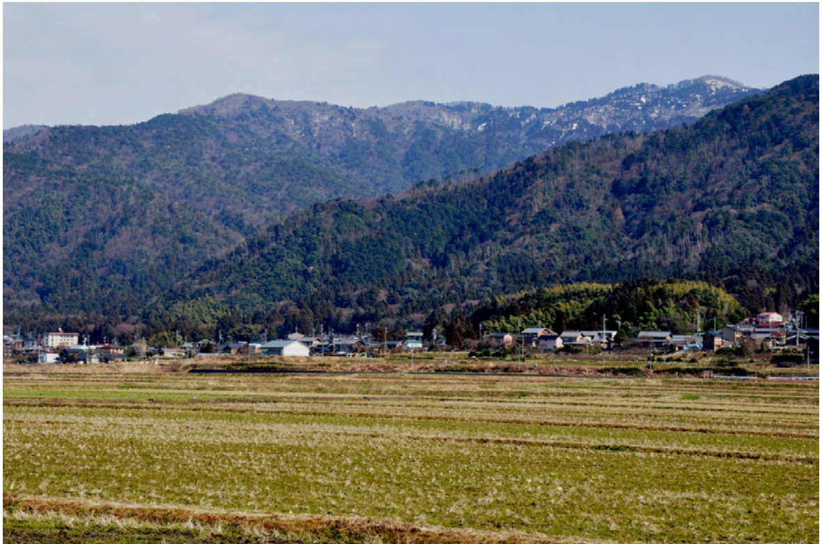
写真 8 若狭町南前川付近の断層崖と低断層崖（南前川の西から東方を望む）。
