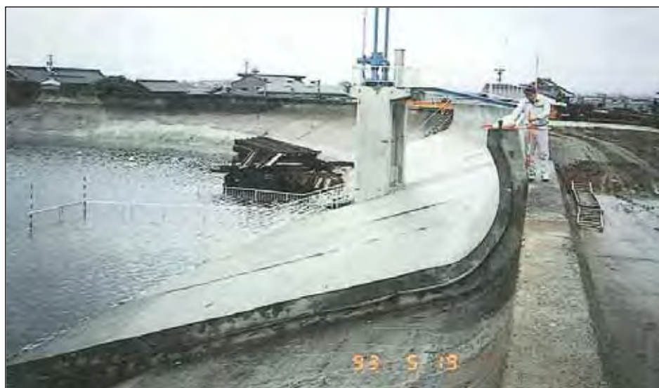
写真 地盤沈下対策河川事業(鍋田川下流排水機場吐出樋門設置工事) 三重県桑名郡木曾岬町源緑輪中(平成5年5月撮影)
