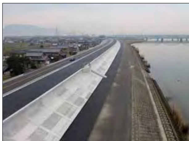
高潮堤防の遠景(平成22年3月撮影)
