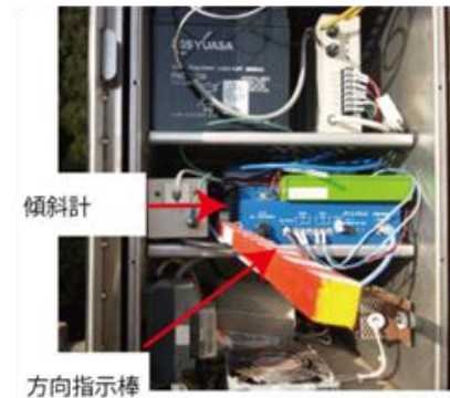
傾斜計の設置状況
