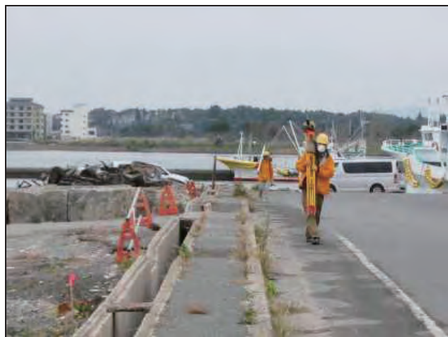
写真-3 「松川浦」地区水準測量実施状況
