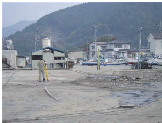
写真-12 「万石浦」地区水準測量実施状況
