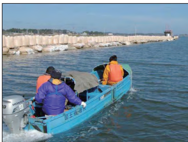
写真-8 松川浦内試走状況
