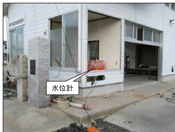
写真-6 水位計本体設置状況
