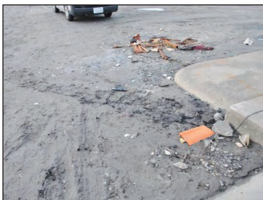
写真-7 センサーケーブル埋設状況
