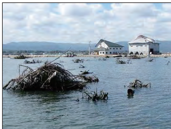
写真-2 松川浦内の状況(平成23年10月20日撮影)
