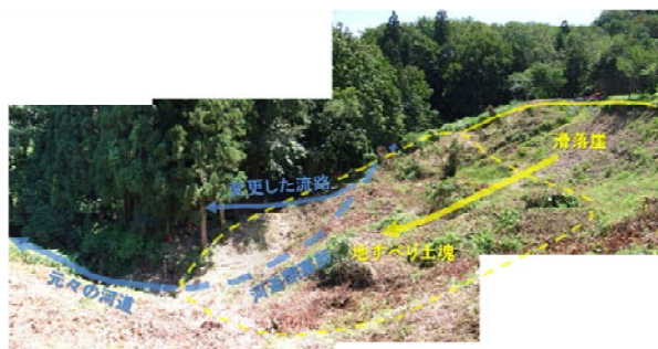
写真-1 河道を閉塞した地すべり土塊の全容（大井平地区）
