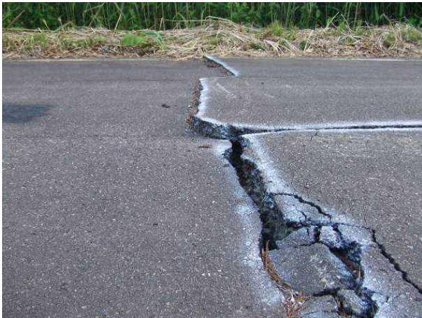
写真-26 大厳寺高原から北方に伸びる広域農道で見られた圧縮性の亀裂（写真撮影位置は図-10 参照）。写真右（北西）から左（南東）に向かってアスファルトが乗り上げている。右横ずれ成分を持つ。
