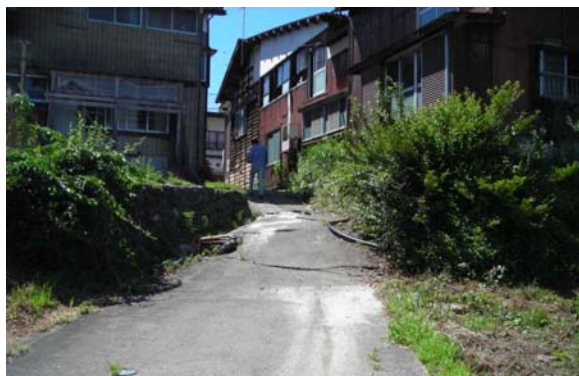
写真-10 森地区の被災家屋が載る盛土。写真の撮影方向は図-7 中に示している。
