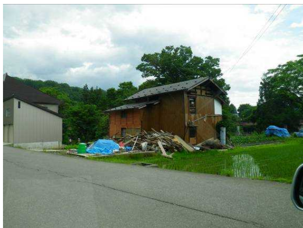
写真-11 被災家屋（青倉地区）
