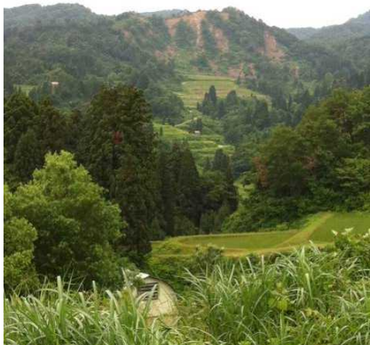
写真-23 大巖寺牧場東方の山地斜面の斜面崩壊 (崩壊位置は図-10 参照)。松之山天水越地区から望む。
