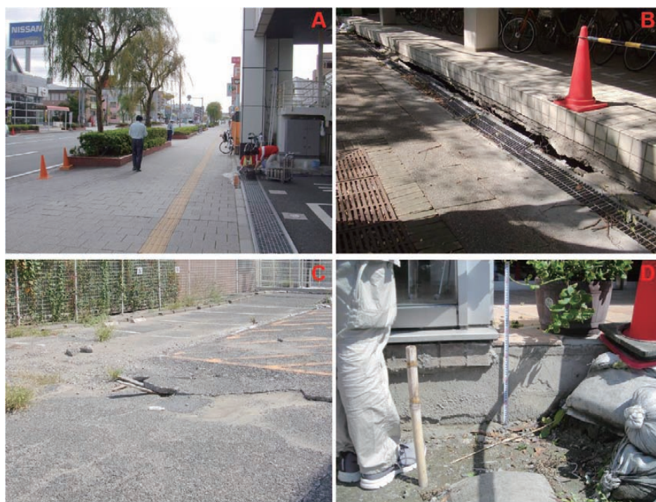
図－9 浦安市の液状化の様子。A～Dの撮影場所は図－8 (a) を参照のこと。
