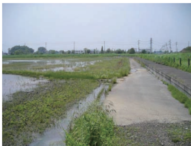
写真-2 旧河道内の様子。全体に沈下して浸水
