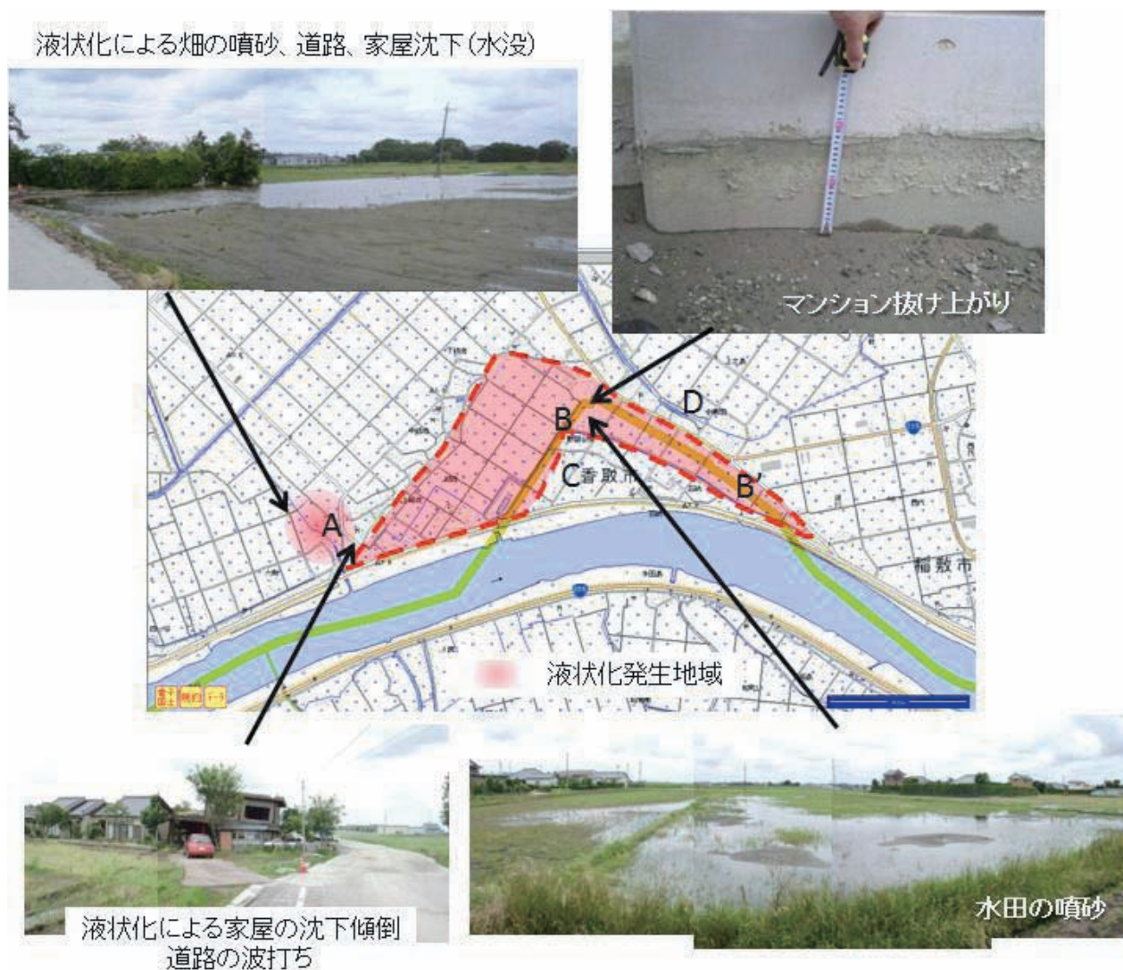
図-11 稲敷市結佐, 香取市石納地区の主な液状化の様子(背景図は電子国土Webシステムを使用)
