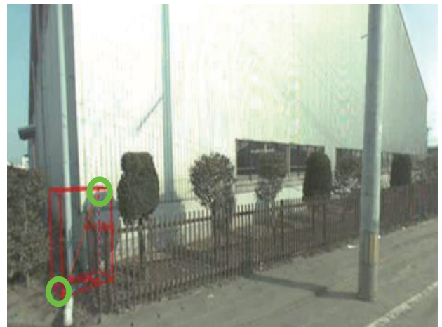
図－11 津波の浸水深の計測の状況
