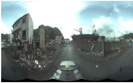
写真-7 撮影した360°画像データの映像の再生 (釜石市)
