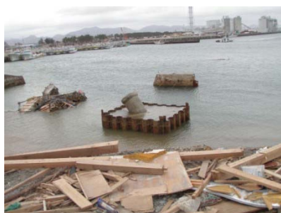
写真-3 相馬験潮場の被害の状況 相馬験潮場中央には傾斜した観測井戸のみ残る。（2011年4月19日撮影）
