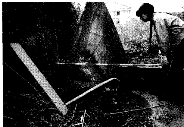
写真-9 北淡町野島墓浦の断層亀裂
