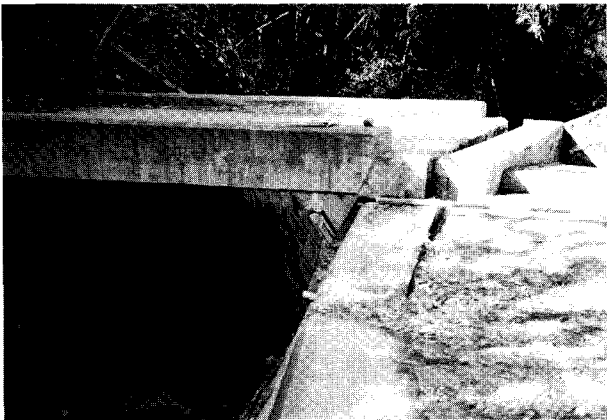
写真-5 北淡田野島江崎の橋及び護岸の状況
