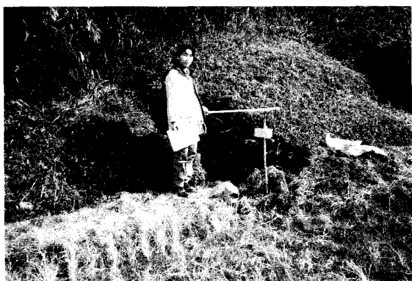
写真－2 北淡町野島江崎の断層亀裂
