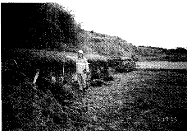
写真-6 北淡田野島平林の断層亀裂
