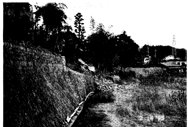
写真-7 宝塚市段丘崖の崩壊と家屋の倒壊
