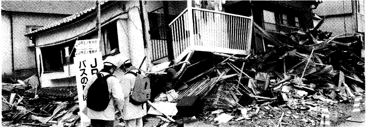
写真－1 住吉駅南部の緩扇状地の建物の被害状況
