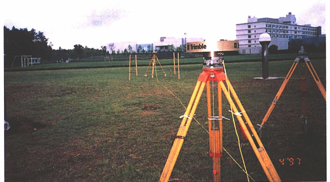
写真－1 アンテナの設置状況
