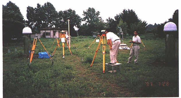
写真-2 アンテナ高の測定状況
