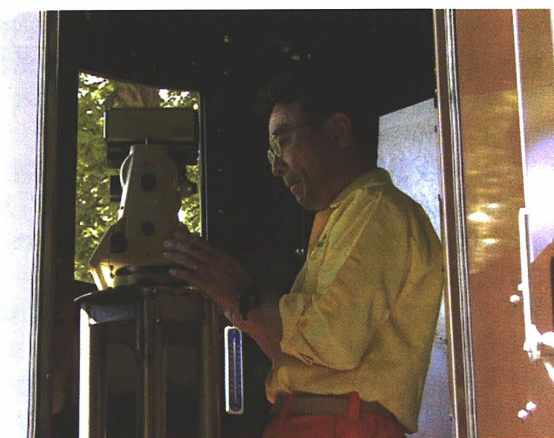
写真-17 APS測量機のセットアップ
