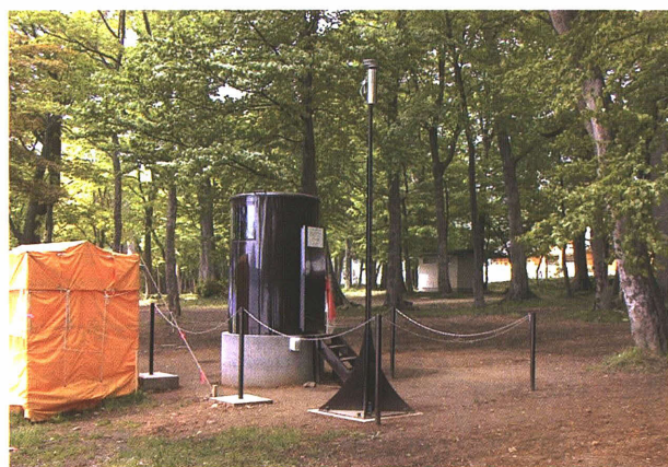
写真-13 局舎及び気象ポール(仲洞爺観測点) (局舎左は、手動測距のG-B点)
