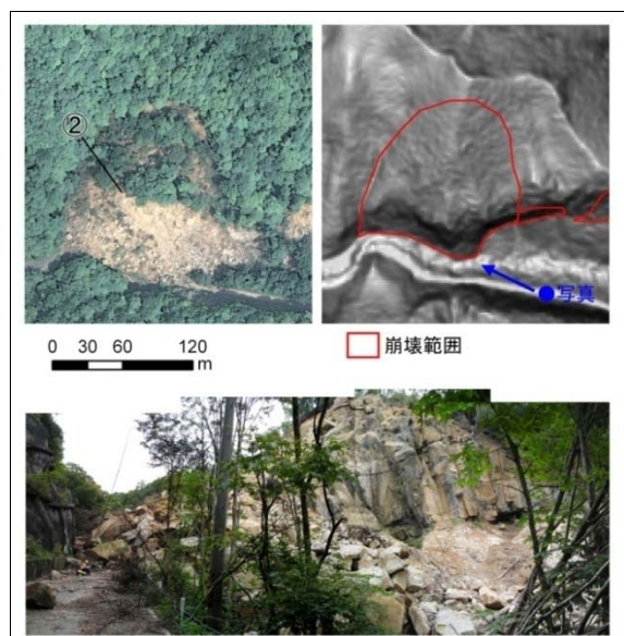
図－4 地点②のオルソフォト画像（左上），発災前の傾斜図（右上），現場写真（下）。
