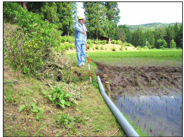
写真－1 栂木立地区の水田・畦道の変状（6 月 16 日撮影）
