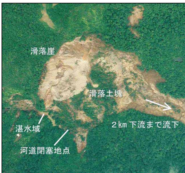
写真-8 産女川上流の崩壊と河道閉塞地点及び湛水域 アジア航測（株）撮影空中写真 C12-0452 に加筆
