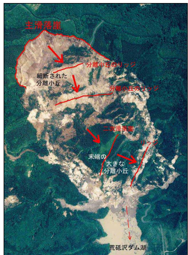
写真－５ 荒砥沢ダム北方の地すべりと滑落土塊推定移動方向 国土地理院撮影空中写真 C6-0969 に加筆
