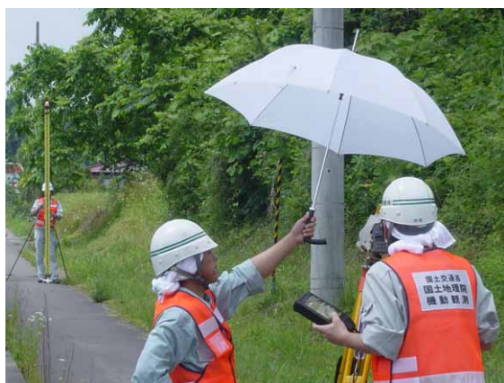
写真-8の2 安全ベストを着用しての作業
