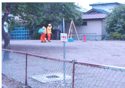
写真-11 No.5444 での GPS 測量の様子
