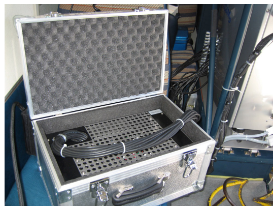
写真－5 MSU（SCU 接続時）
