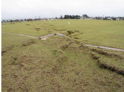
図-13 鯖石川河川改修記念公園の亀裂（図-12 の C1, 図-16 の A-A'）
