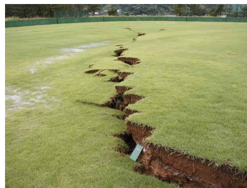
図-27 西山野球場の段差 40cm の亀裂
