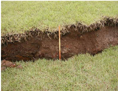
図-14 段差 40cm の亀裂（図-12 の C1, 図-16 の A-A'）
