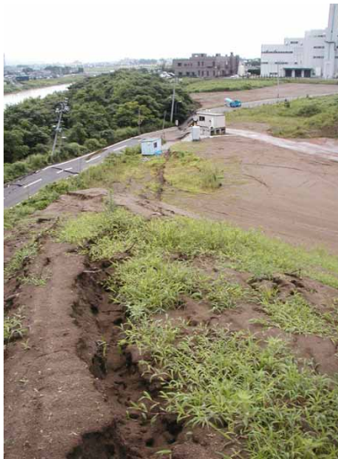
図-19 亀裂が砂丘の中まで連続（図-12 の d2）
