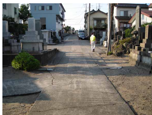
図－5 斜面上部の開口割れ目（図－3のa3）
