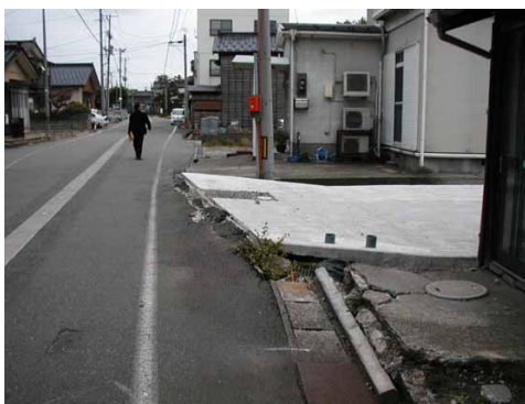
図－9 柏崎市街地北側の圧縮変形（図－3のa6）
