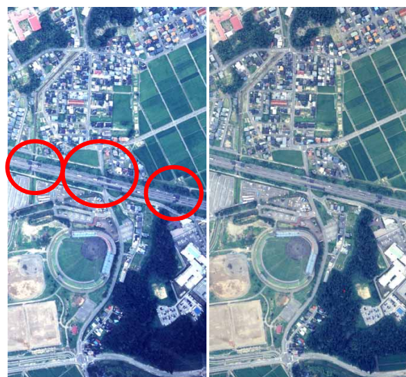
写真-15 道路の損壊（北陸自動車道「運動広場付近」）（立体視可能）
