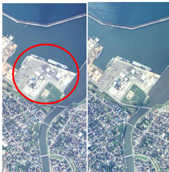
写真-14 液状化・噴砂（柏崎港）（立体視可能）
