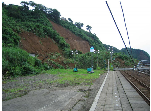
写真－9 JR 青海川駅西方の斜面崩壊
