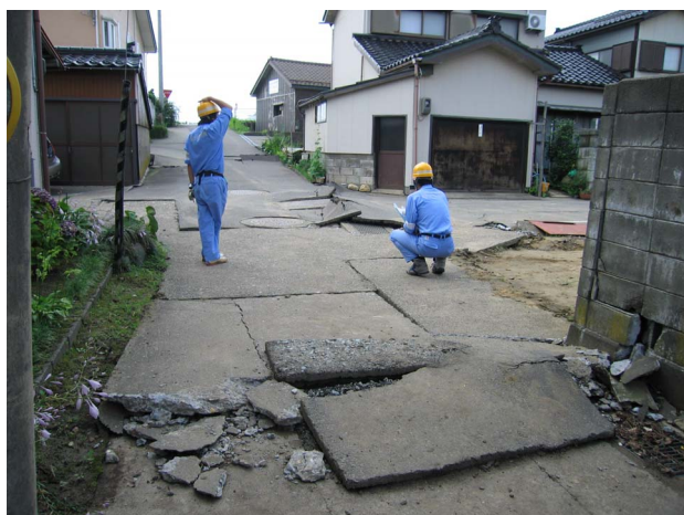
写真-11 手前にずり落ちるようにして生じた西元町の圧縮亀裂
