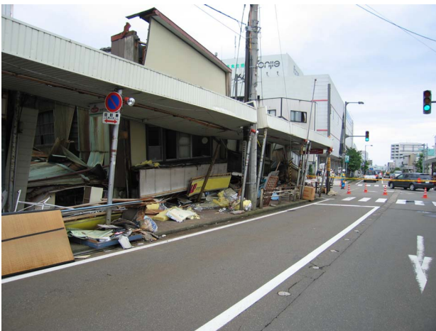
写真－8 倒壊した商店と傾いた雁木
