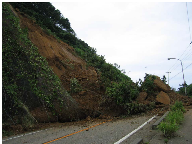
写真-10 のり面上方の斜面崩壊（観音岬）
