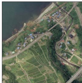
土砂崩れ (JR 青海川駅周辺)
