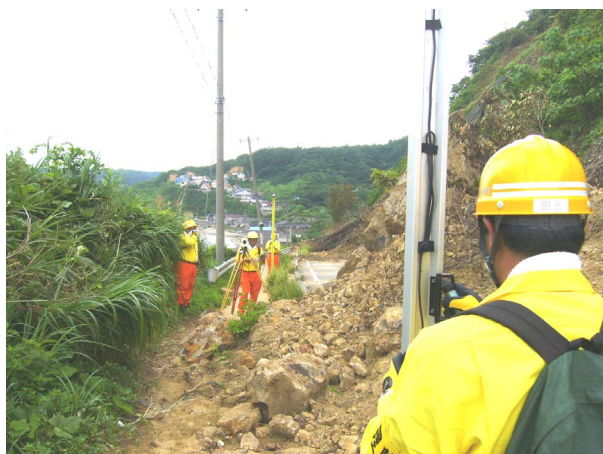
写真－4 観音岬の斜面崩壊現場での観測
