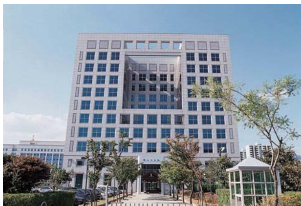
写真－1 国土研究院の建物
