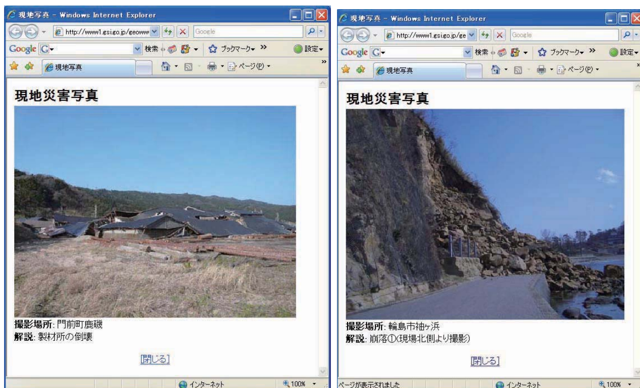
図-19 現地災害写真
