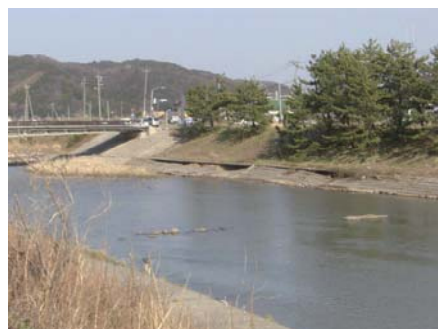
(c) 八ヶ川の堤防の破損
