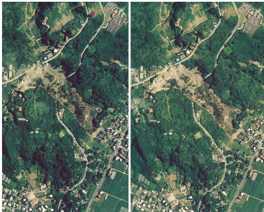
図一2 地すべり後の空中写真(国土地理院撮影)
