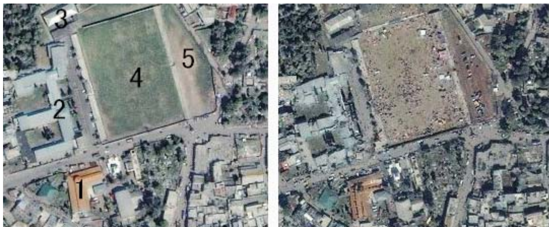
図 4 図 3 の「7」に示した地点周辺の建物倒壊
