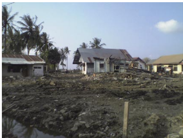
写真－14 現地検証写真の例（1）
