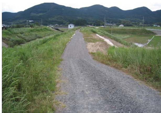
写真-14 桶寄川越水箇所
