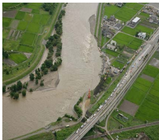
写真－4 天竜川の堤防決壊。撮影方向は図－8参照 （7月20日、(株)パスコ・国際航業(株)撮影）
