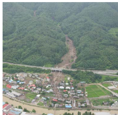
写真-2 岡谷市川岸東2丁目の土石流、撮影方向は図-6参照(7月20日, (株)パスコ・国際航業(株)撮影)
