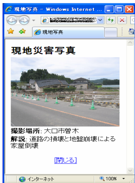
図-23 現地災害写真
