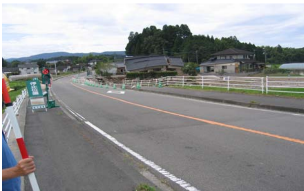
写真-12 国道 267 号上より
