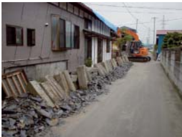
写真-16 砂押地区における家屋被害
