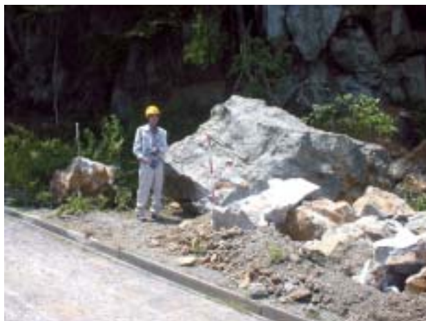
写真ー10 落石による石灰岩の岩塊
