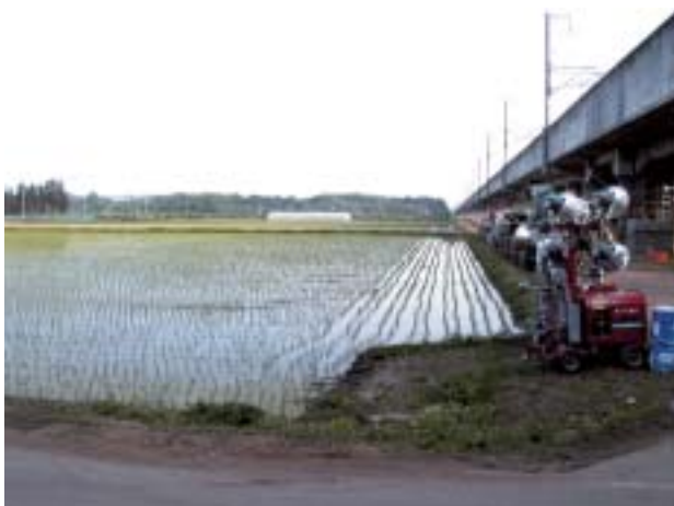
写真-6 損傷箇所付近の河岸段丘面
