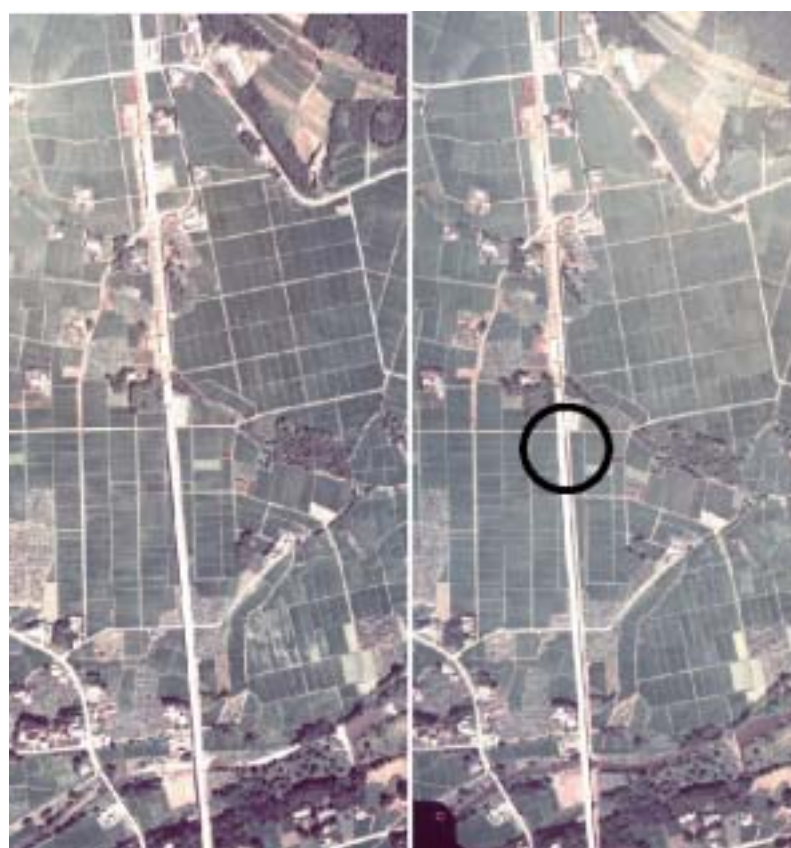
写真一 5 橋脚損傷箇所付近の空中写真
