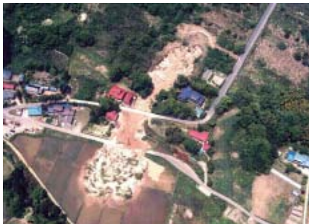
写真－1 斜面崩壊の状況（アジア航測撮影）
