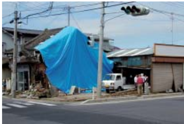
写真－3 電子基準点「矢本」付近の倒壊家屋
