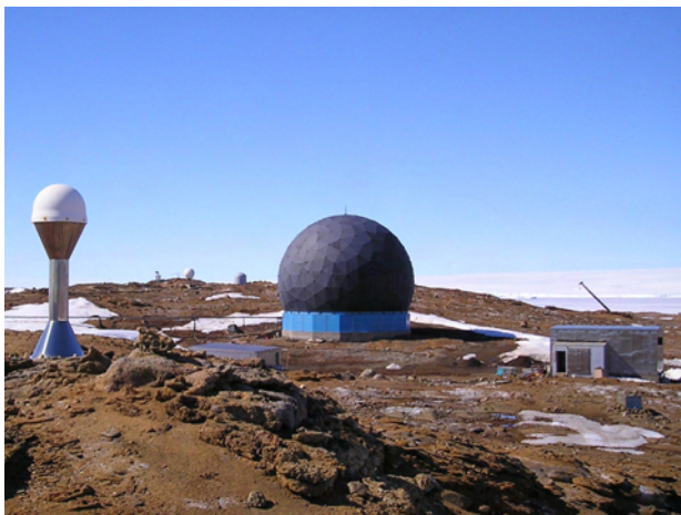
写真-1 昭和基地の測地観測施設
