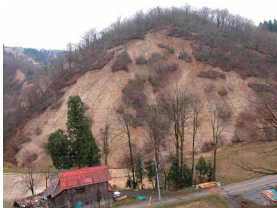
写真－２ 崩壊B (旧山古志村池谷 平成16年11月30日撮影)
