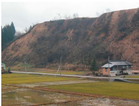
写真－１ 崩壊A (旧堀之内町竜光 平成16年11月29日撮影)
