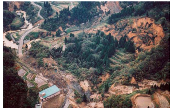
写真－４ 地すべりA (旧山古志村東竹沢 平成16年10月中日本航空撮影)
