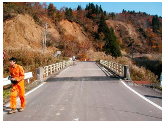
写真－３ 崩壊C (旧山古志村種芋原 平成16年11月7日撮影)
