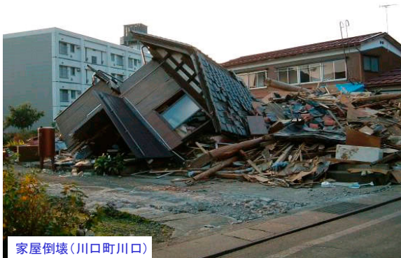
写真－3 家屋倒壊
