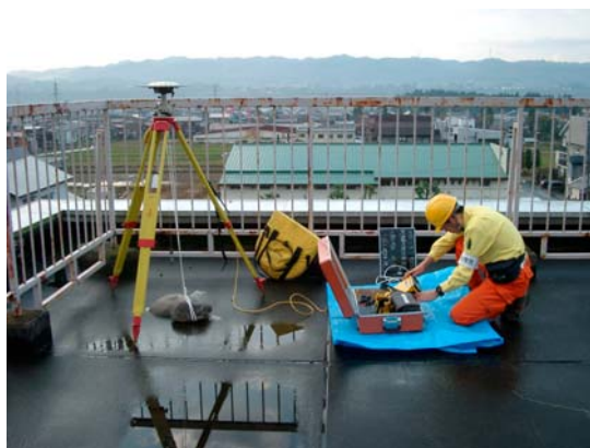
写真－10 屋上点の観測準備 (魚沼市)
