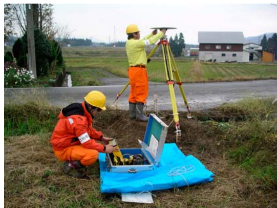
写真－9 GPS アンテナの設置 (小千谷市)
