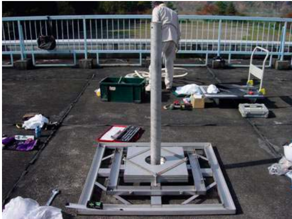
写真-1 アンテナ架台
