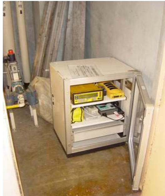
写真-4 収納ラック
