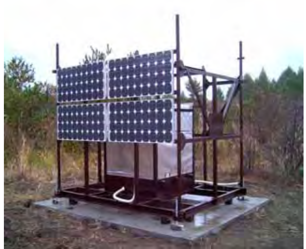
写真－6 M浅間砂塚の基礎
