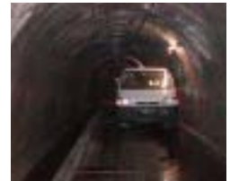
写真－6 作業坑内の作業車
