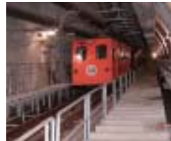
写真－5 竜飛側斜坑
