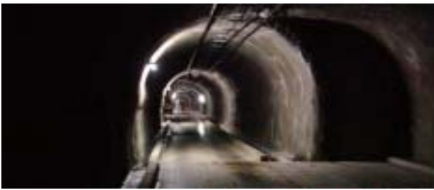
写真－4 青函トンネル作業坑
