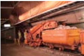
写真－2 竜飛海底駅付近
