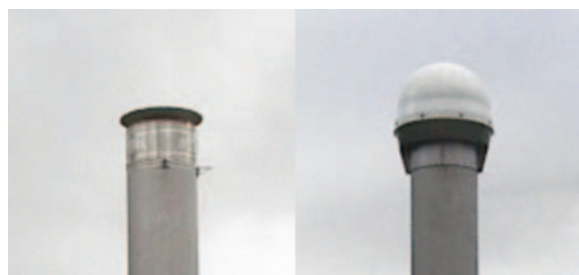
写真-5 レドーム交換・設置 (設置前(左)と設置後(右))
