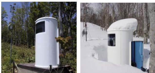
写真－1 観測局舎
